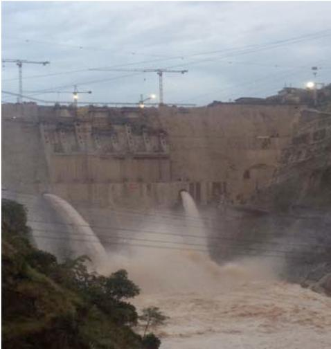
della portata massima di 800 m<sup>3</sup>/sec per un totale di 1600m<sup>3</sup>/sec, concepiti per ricreare artificialmente le piene naturali del fiume attraverso le quali viene praticata l'agricoltura di recesso. Dopo il collaudo, avvenuto nella seconda metà del 2015, gli scarichi sono stati consegnati al Committente (EEP) che ne cura la gestione, sotto la propria responsabilità e nell'ambito della conduzione ed operatività della Centrale.
