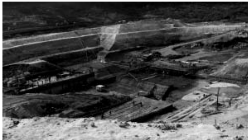
Chantier de construction d'un barrage sur le rio Juruena, au Brésil. © Survival
