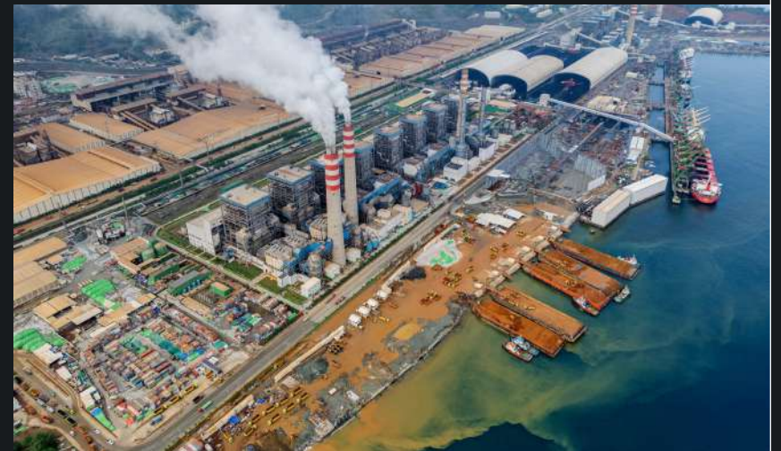
L'enorme complesso Weda Bay Industrial Park (IWIP) sull'isola di Halmahera, Indonesia. L'estrazione del nichel sta distruggendo la foresta del popolo incontattato Hongana Manyawa. © Garry Lotulung
